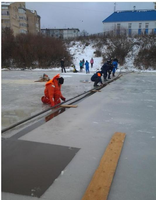
Рис. 3. Установка автоматического гидрологического комплекса на реке Вологде.
