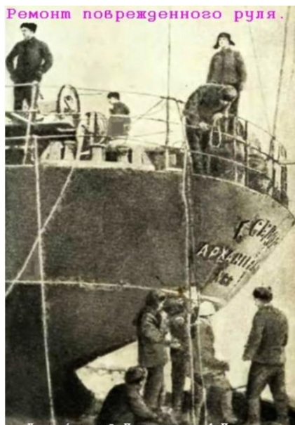
Ремонт поврежденного руля на ледоколе «Георгий Седов».
