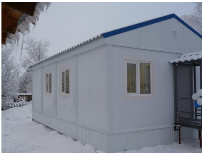
Новый модуль Г-2 Троицко-Печорск Филиала "Коми ЦГМС".
