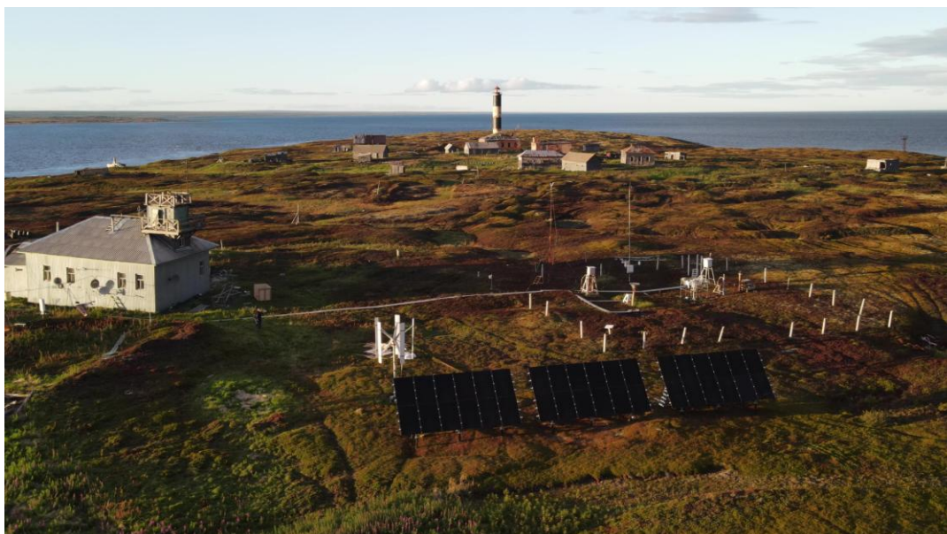
Солнечная электростанция на МГ-2 Сосновец.
