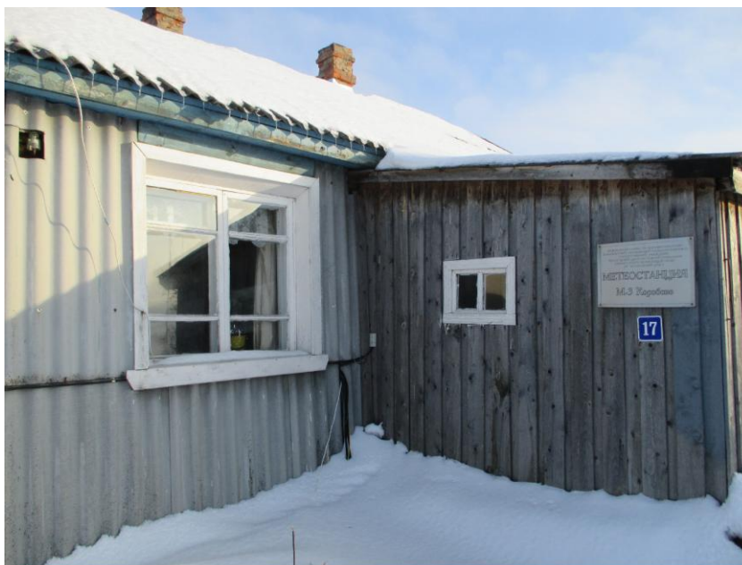
Здание М-2 Коробово.
