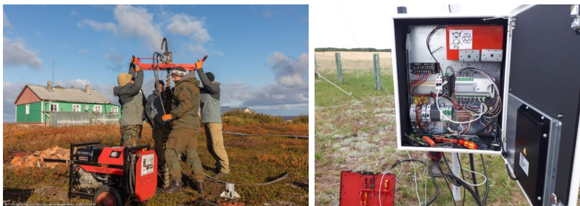
Установка нового АМК на МГ-2 Абрамовский Маяк.
