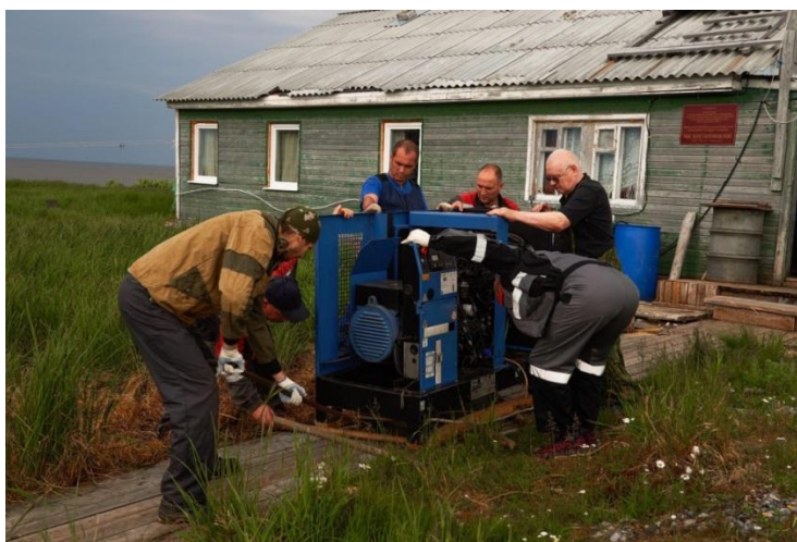
Транспортировка нового дизель-генератора на МГ-2 Мыс Константиновский, сентябрь 2021 г.
