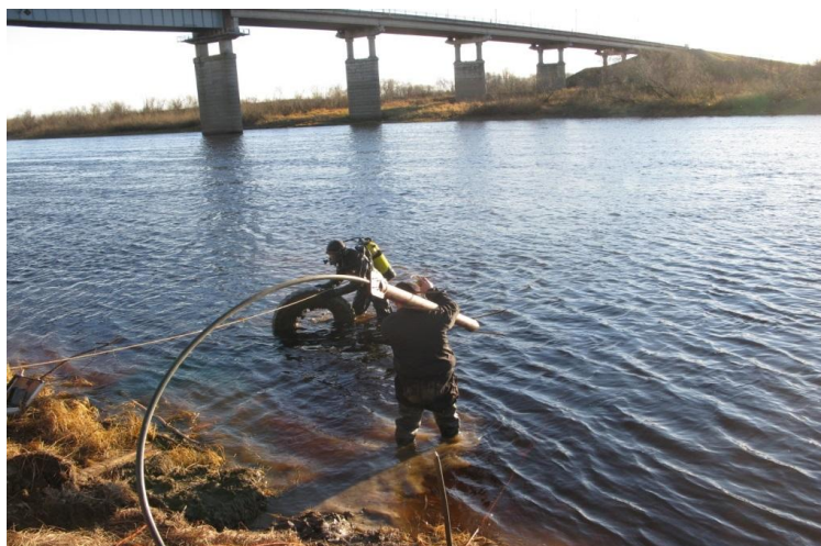
Водолазные работы на посту р. Емца-с. Емецк при установке датчика АГК.
