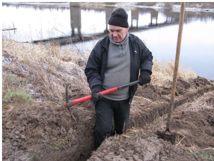
Подготовка траншеи для укладки кабеля АГК на посту р. Емца-с. Емецк.
