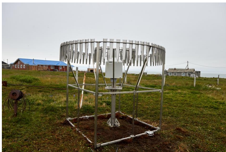
Новый автоматизированный датчик осадков на МГ-2 Бугрино.
