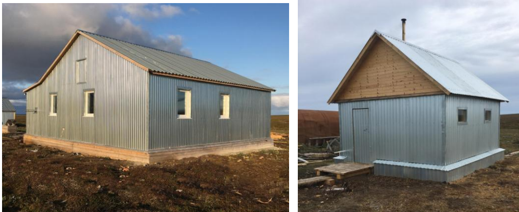
Рис. 9-10. Служебное здание после завершения реконструкции и новая баня на МГ-2 Колгуев Северный.
