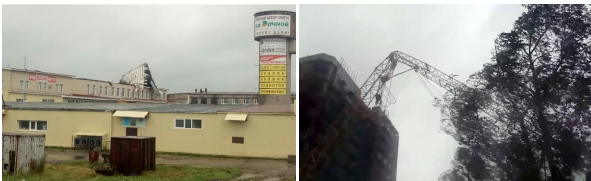
Рис. 3. Разрушения в г.Архангельске 22.08.2018
