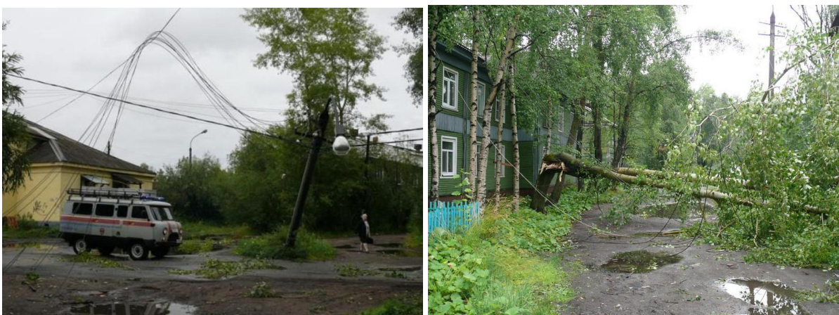
Рис. 4. Оборванные линии электропередач 22.08.2018
