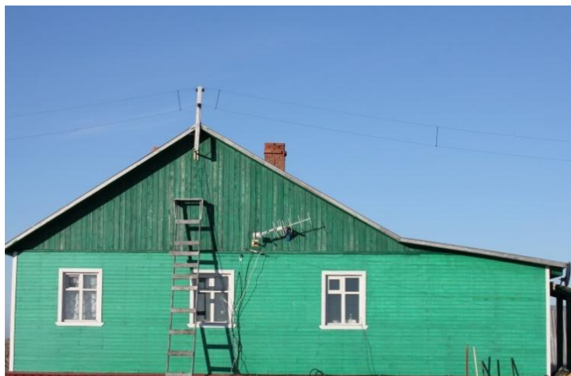
Рис. 1. Радиотерминал АПК ПСД и новая широкополосная антенна КВ радиосвязи на МГ-2 Ходовариха
