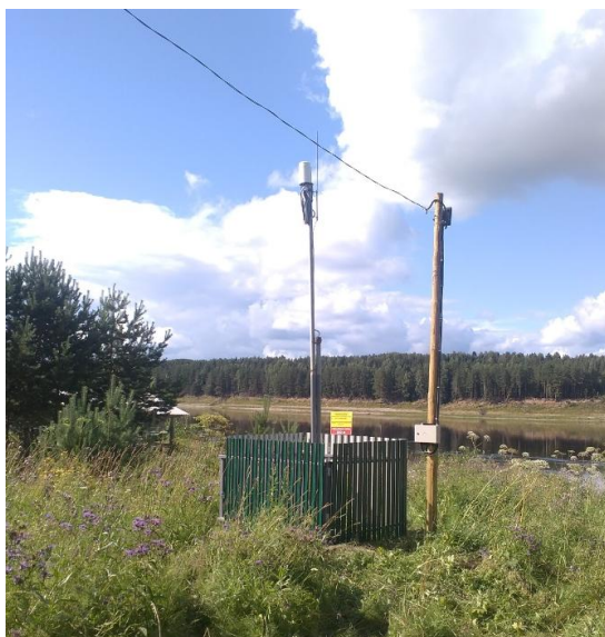
Рис. 1. Автоматизированный гидрологический комплекс на в\п Каликино
