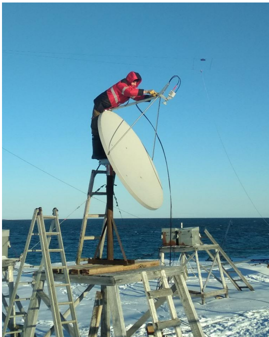
Рис. 2. Установка спутниковой системы связи ССС«VSAT» на МГ-2 им. Г.А. Ушакова
