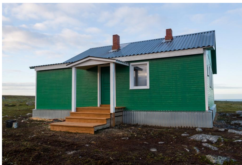
Рис. 8. Служебное здание МГ-2 Канин Нос после реконструкции
